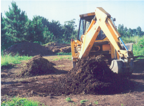
Figura 4. Operación de volteo de las biopilas mediante pala mecánica.
