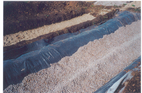
Figura 1b. Construcción de las parcelas experimentales para el tratamiento del suelo mediante landfarming . Fase de impermeabilización e instalación del tubo de drenaje para recogida de lixiviados.
