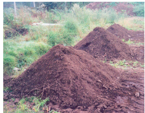
Figura 3. Tratamiento del suelo contaminado mediante formación de biopilas.
